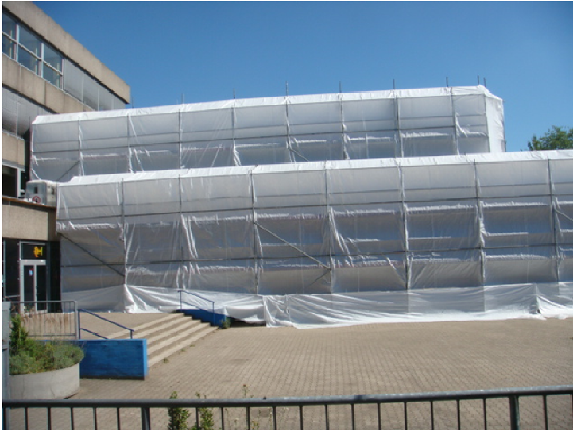
Abb. 3: Ansicht des Gebäudes während der Sanierung
