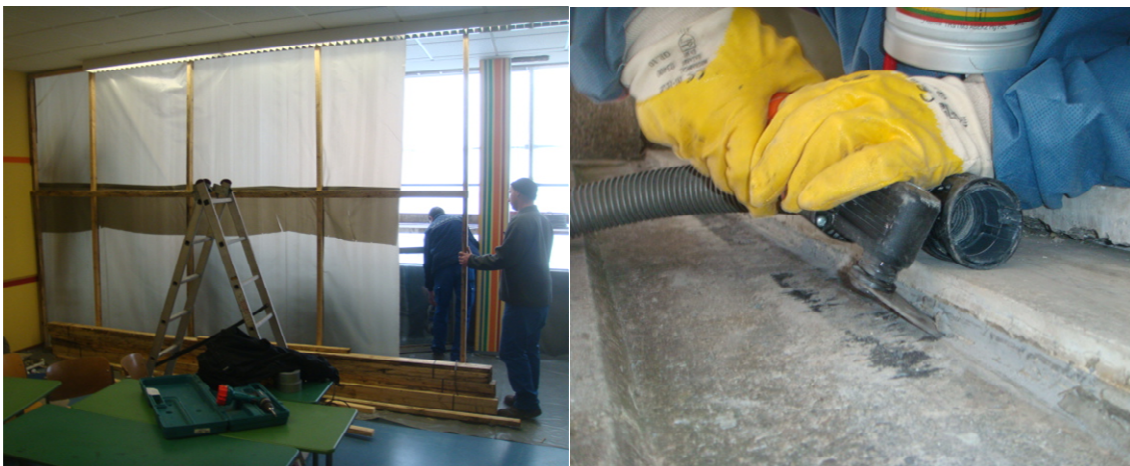
Abb. 2: Probesanierung – Aufbau des Containments, Entfernen der Fugenmassen
