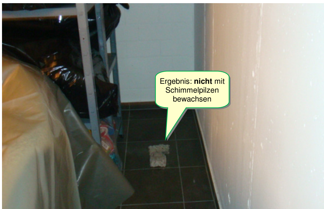
Abb. 4: Fußboden unterhalb Fenster ohne Befall
